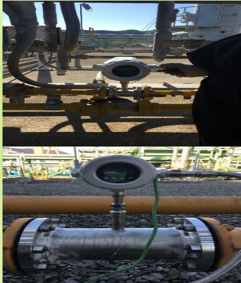
한국가스공사(삼척&통영기지) Flare Stack Fuel Gas & LNG Main공급용~ 3대납품 열질량유량계
