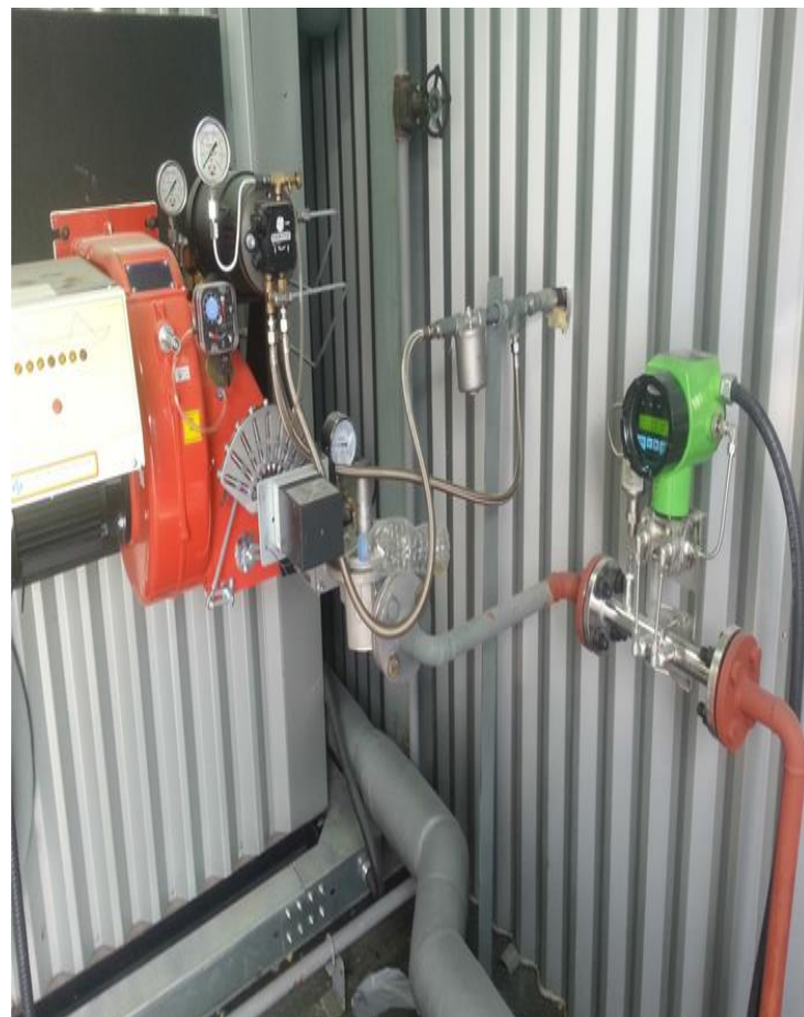
이천(잔존사체처리시스템) LPG, 25A 라인 FN질량유량계
